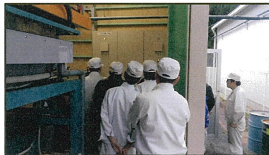
【排水処理施設の操作盤の前で緊急停止方法について説明を受ける】
